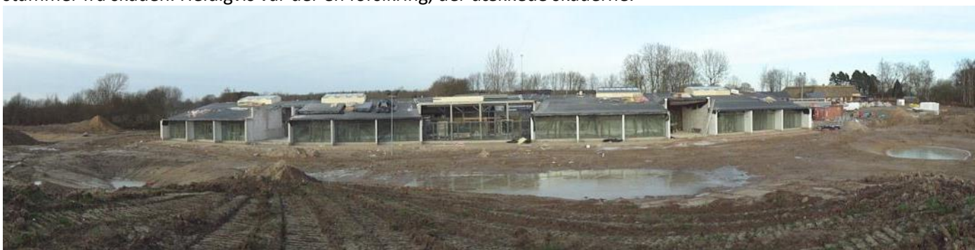
Byggepladsen (patientfløjene) den 14. januar 2012 – 12 dage før rejsegildet (Foto Niels Ole Nielsen)
