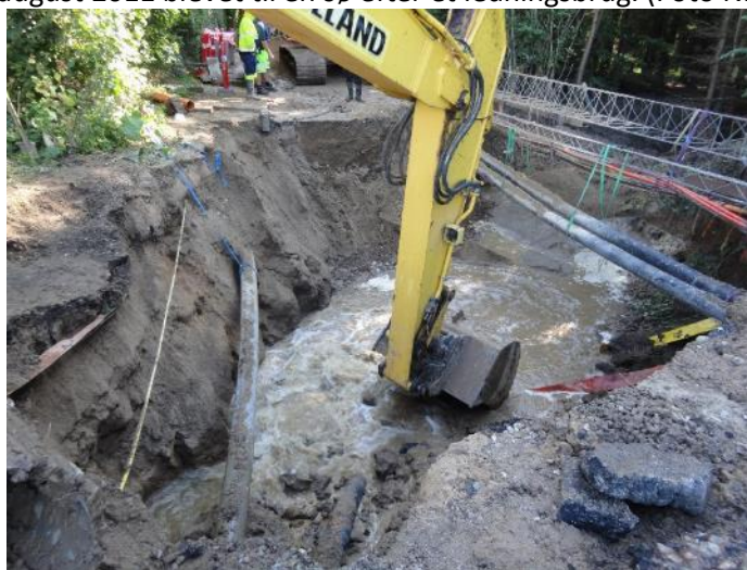
Der graves for at udbedre bruddet (Foto: Niels Ole Nielsen)
