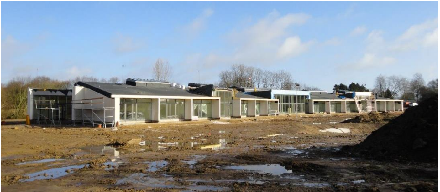
Byggepladsen (patientfløjene) den 17. februar 2012 (Foto Niels Ole Nielsen)
