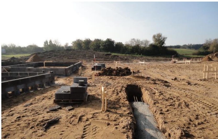
Byggepladsen den 17. oktober 2011 (Foto Niels Ole Nielsen)
