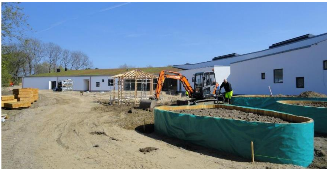
Det grønne tag er lagt på, og der arbejdes med sansehaven den 30. april 2012 (Foto Niels Ole Nielsen)
