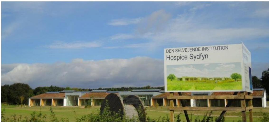
Dagen for aflevering af byggeriet den 3. september 2012 (Foto Niels Ole Nielsen)
