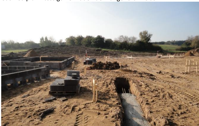
Byggepladsen den 17. oktober 2011 (Foto Niels Ole Nielsen)
